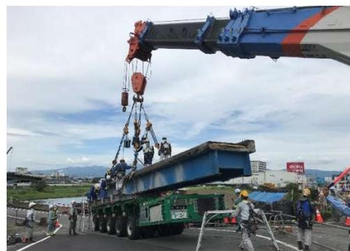
写真 6 多軸台車への橋桁の搭載状況
