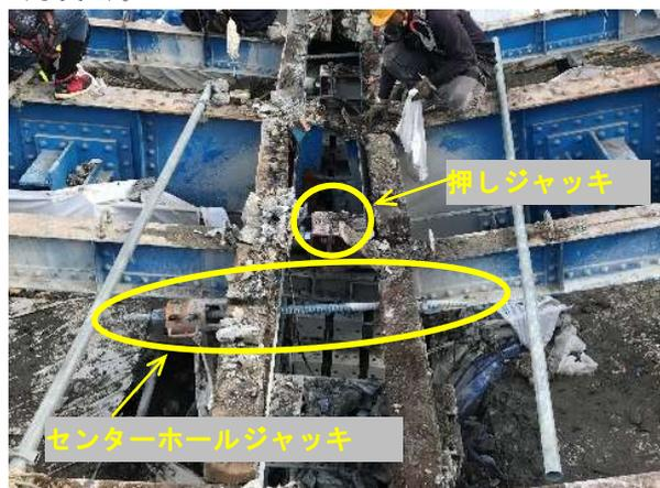
写真 5 端対傾構へのジャッキ設置状況
