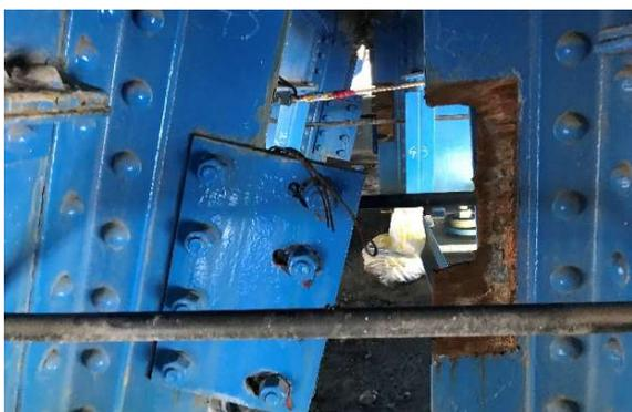
写真4 P4橋脚 桁連結板の破断状況
