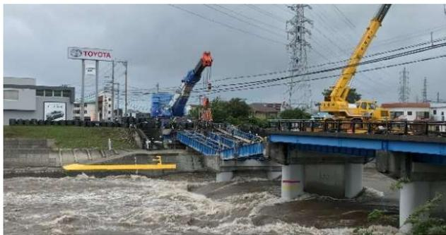
写真 7 高水位状態での橋桁撤去状況
