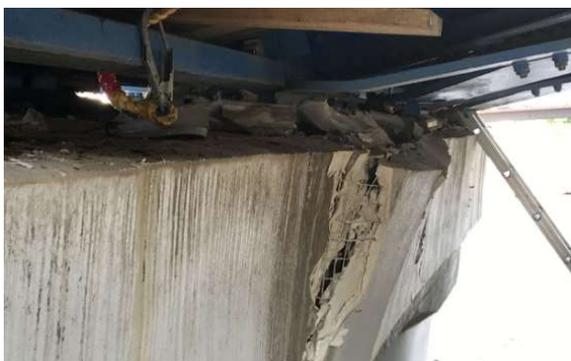
写真3 P4橋脚 杓座の破損状況
