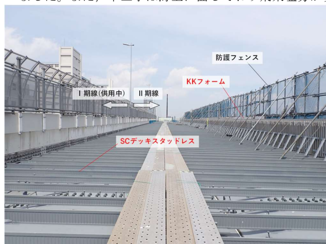
写真1 Ⅱ期線施工状況
