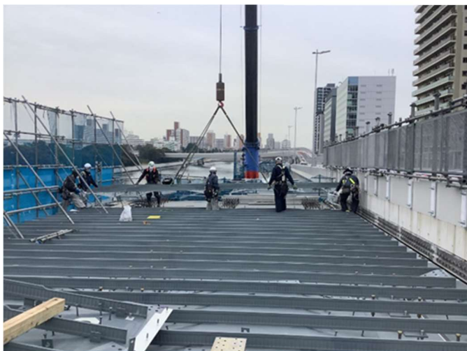
写真2 合成床版底鋼板架設状況
