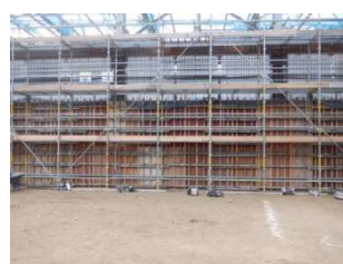
写真 6 1 段目型枠建込状況
