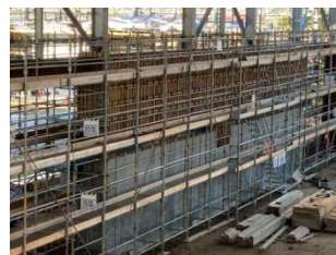
写真 8 2 段目型枠建込状況
