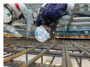
写真 7 生コン打設状況
