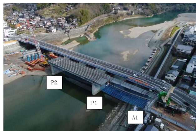
写真4 両岸並行作業全景
