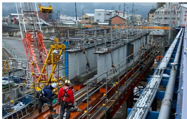
写真2 主桁2組組立状況
