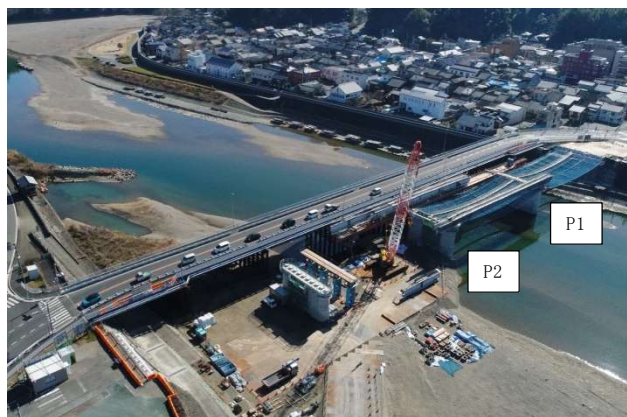
写真1 P1-P2 径間架設全景
