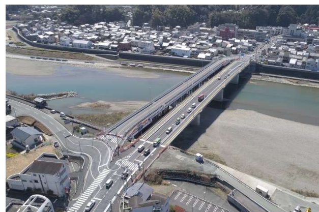
写真5 工事完成・開通
