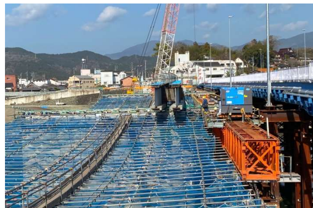
写真3 主桁2組横取状況
