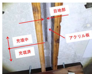
写真3 モルタル充填確認状況
