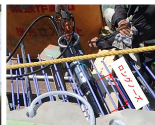
写真4 1次ケーブル緊張状況
