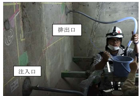
写真1 グラウト再注入状況（圧入方式）
