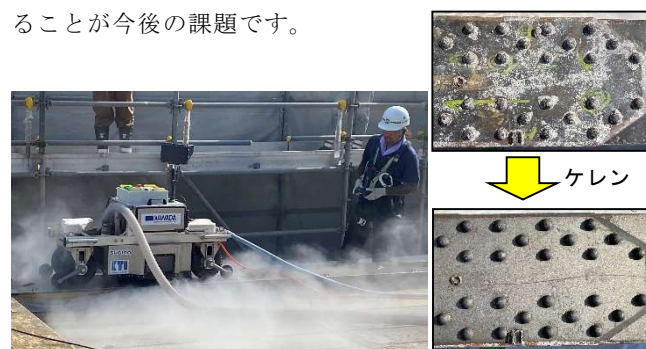
写真4 施工現場でのケレン作業
