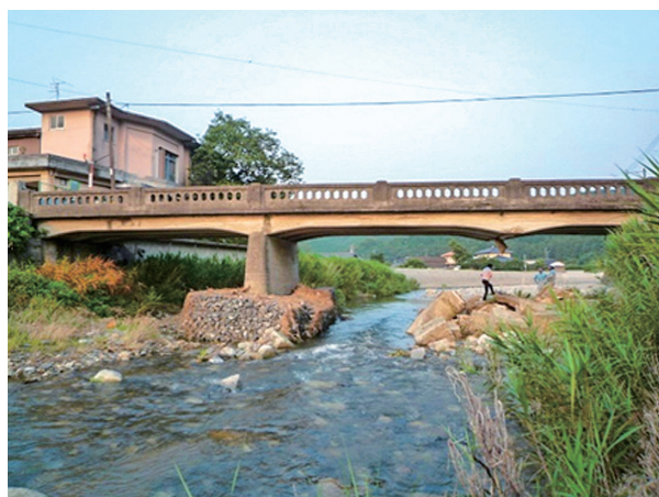
図9 橋脚が倒壊した橋梁
