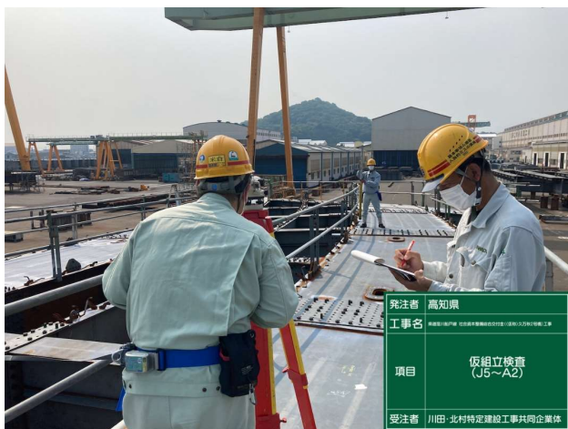
写真 3 J5-S2 間の主桁上面標高の実測状況
