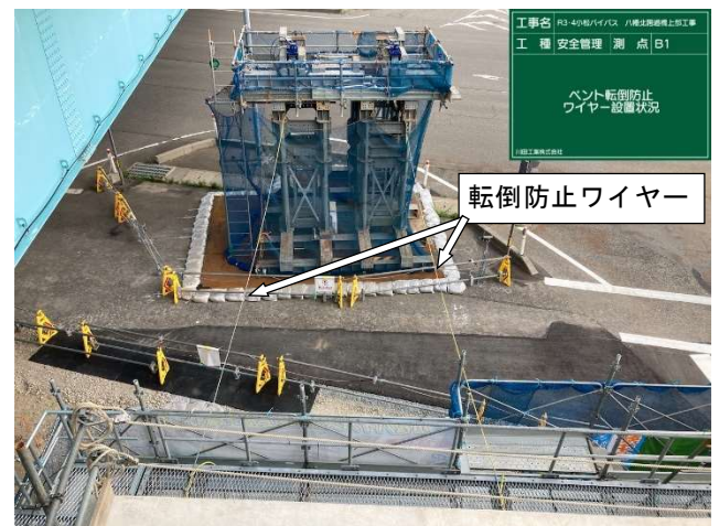
写真 3 転倒防止ワイヤー設置状況
