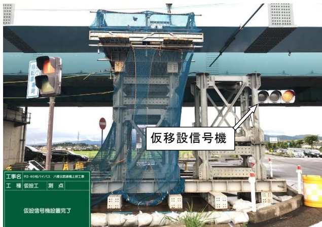
写真 1 信号機仮移設状況
