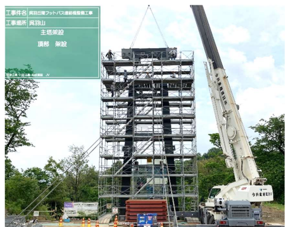
写真3 主塔架設の状況
