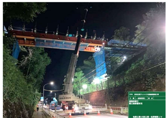
写真2 道路防護工の設置状況
