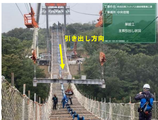
写真5 1本目の主索の引出し状況
