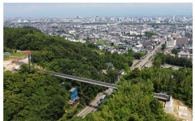
写真 1 呉羽丘陵フットパス連絡橋の全景
