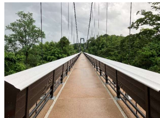
写真10 高欄設置後の状況
