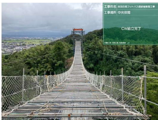
写真4 キャットウォークの設置後の状況
