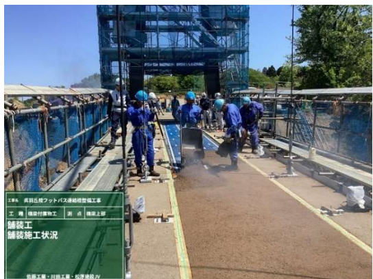
写真9 舗装の敷設状況
