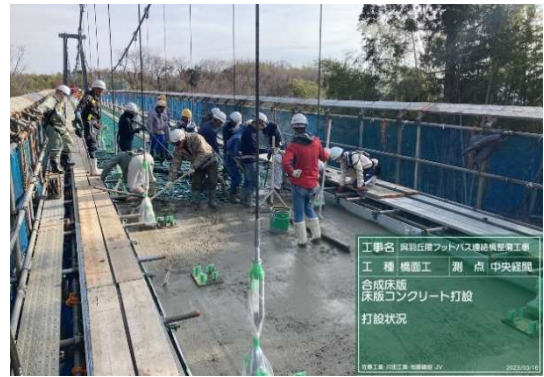
写真7 床版コンクリートの打設状況
