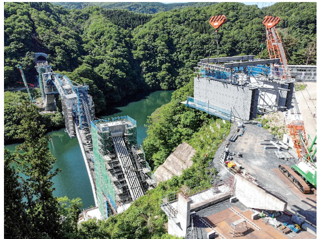
写真4 ケーブルクレーンによる鋼メラン材吊上げ
