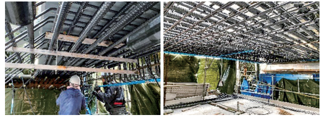
写真7 鉄筋先行組立て状況
