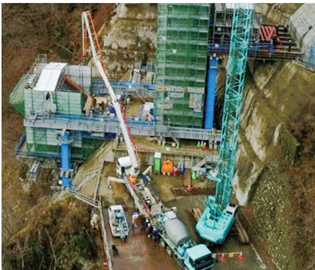
写真1 スプリング部吊り支保工施工状況
