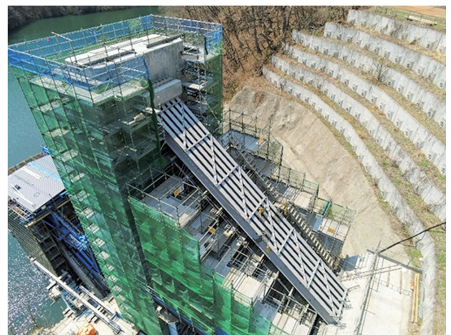
写真3 エンドポスト頂部固定状況
