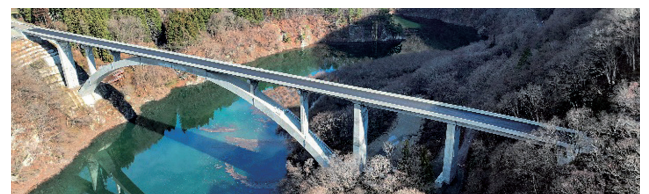
写真12 下郷大橋完成写真
