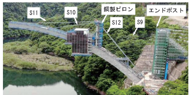
写真5 鋼メラン材架設状況
