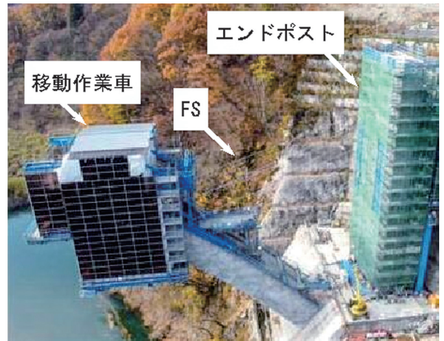
写真2 移動作業車による斜吊り張出し施工状況
