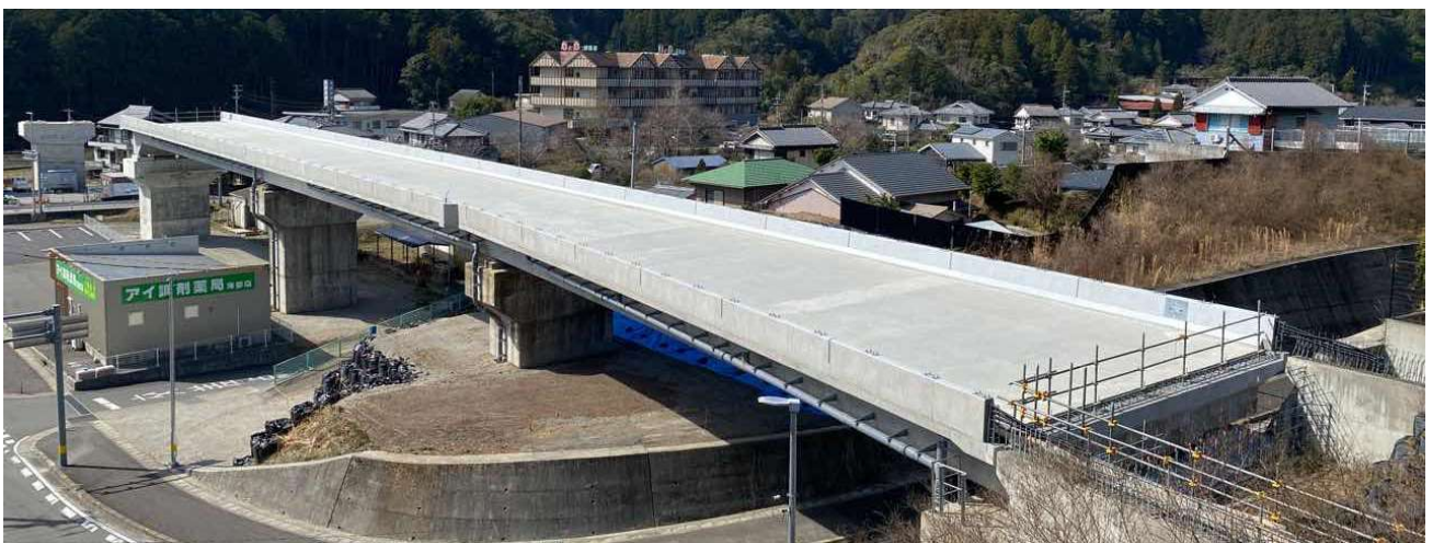
写真9 橋梁完成写真
