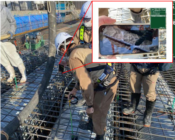
写真8 充填状況監視状況 「CCDカメラ」使用
