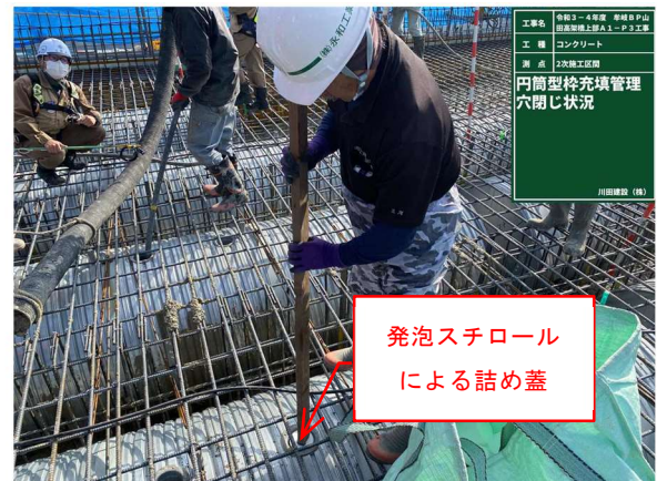
写真 6 コンクリート流入対策
