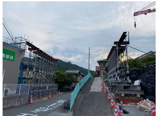
写真2 勾配に沿った支柱配置
