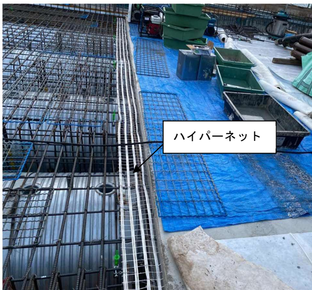
写真 5 ハイパーネット設置状況
