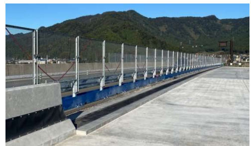
写真12 縦目地伸縮装置施工完了
