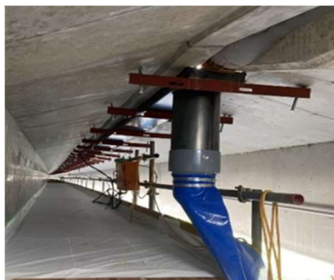
写真3 仮設鋼製受樋設置
