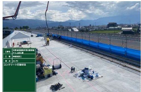
写真10 縦目地伸縮装置後打ちコンクリート打設
