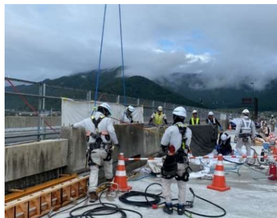
写真5 既設壁高欄撤去状況
