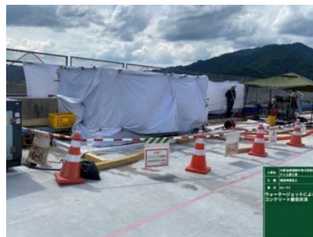
写真6 WJ工法(機械施工)による切欠き施工
