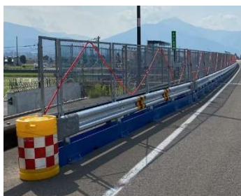
写真2 仮設防護柵設置
