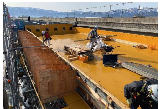
写真 1 型枠組立状況
