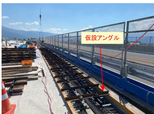
写真8 伸縮装置受台 地組設置
