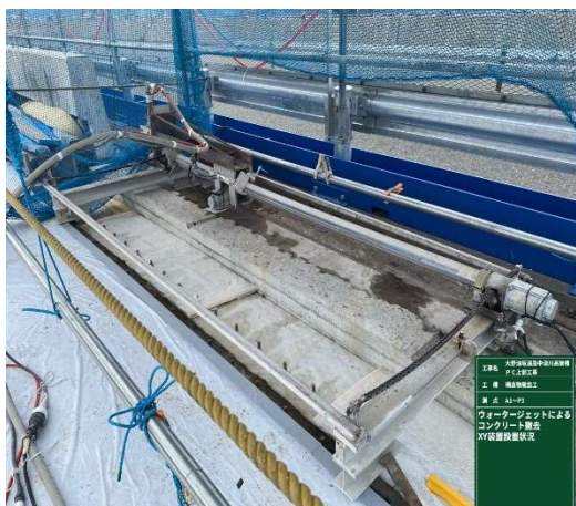
写真13 ウォータージェットXY移動はつり装置
