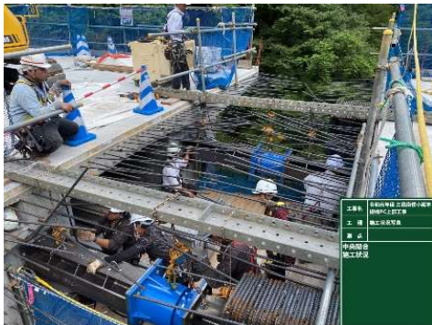
写真 1 ジャッキ設置状況
