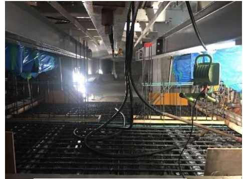
写真 3 ジャッキ設置完了
