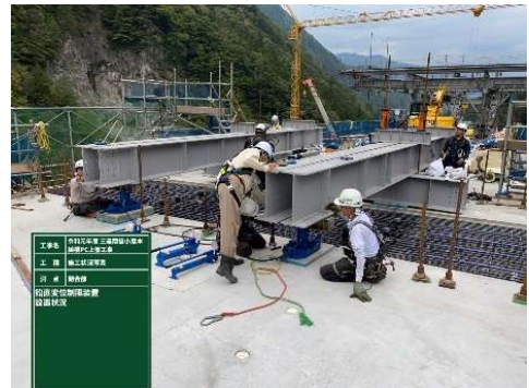
写真 4 鉛直変位制限装置設置
