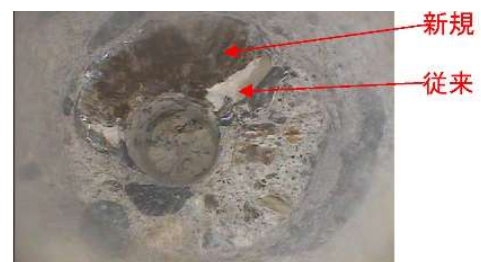
図4 陰影部グラウト注入確認
