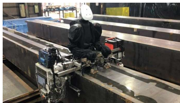
写真6 2線同時自動探傷装置運転時
