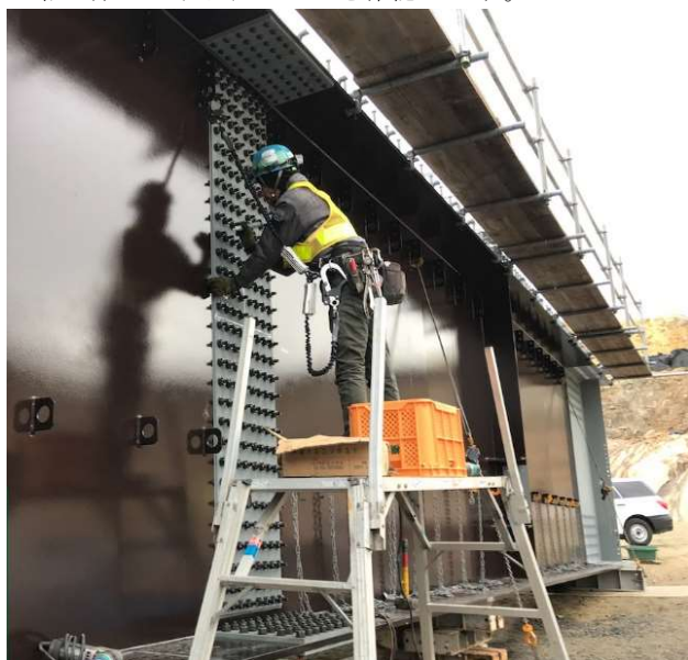
写真1 ボルトマーキング状況
