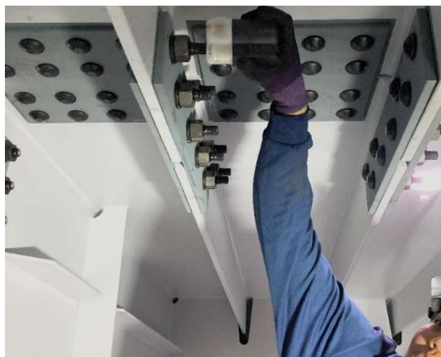
写真4 狭隘部での施工状況
