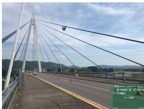
写真 1 橋梁の全景とケーブル被覆の詳細点検状況
