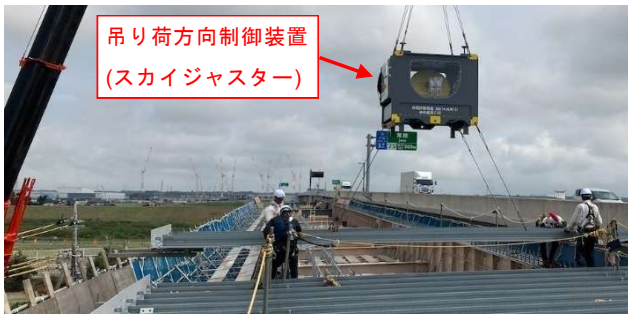
写真1 合成床版架設状況
