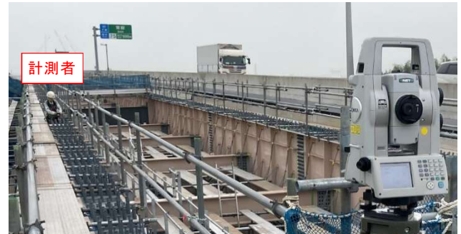
写真3 ワンマン測量実施状況
