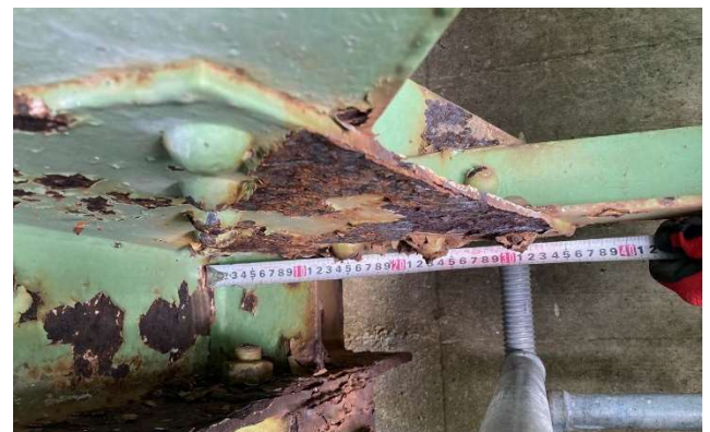
写真3 既設下横構ガセットプレート計測状況
