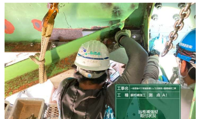
写真4 既設下横構と当て板補強材取付状況
