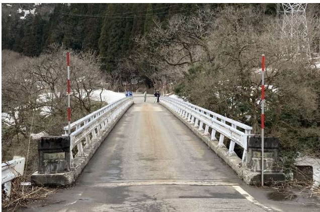
写真1 着工前現地状況 (A1側よりA2側を望む)
