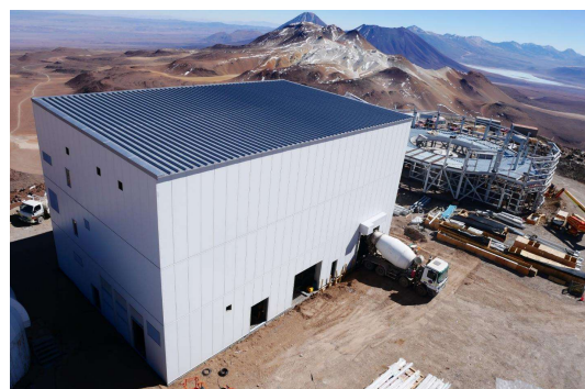
写真 6 外装工事完了 (高所作業車から撮影)
