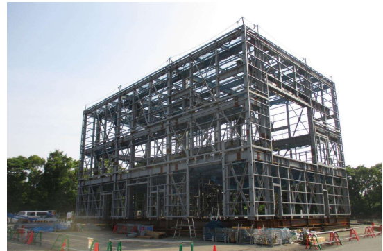
写真 1 日本での仮組立状況
