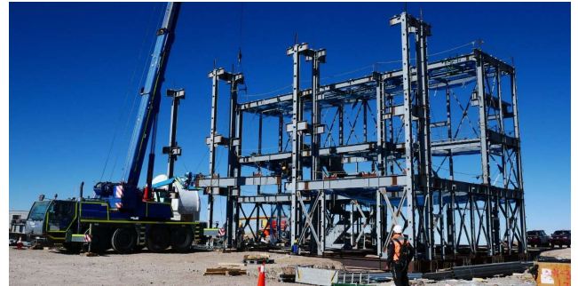
写真 4 鉄骨建方状況
