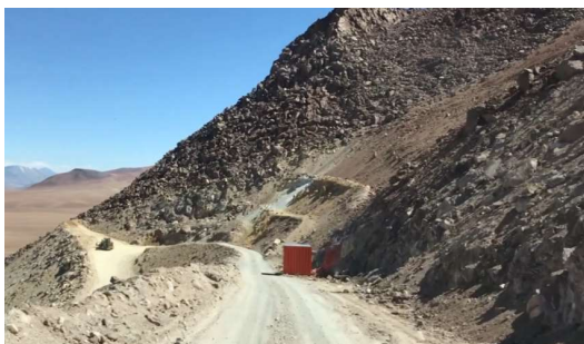
写真 3 仮置場ヤードから山頂までの道路
