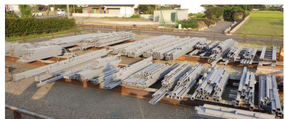
写真 2 解体した鉄骨部材の仕分け状況
