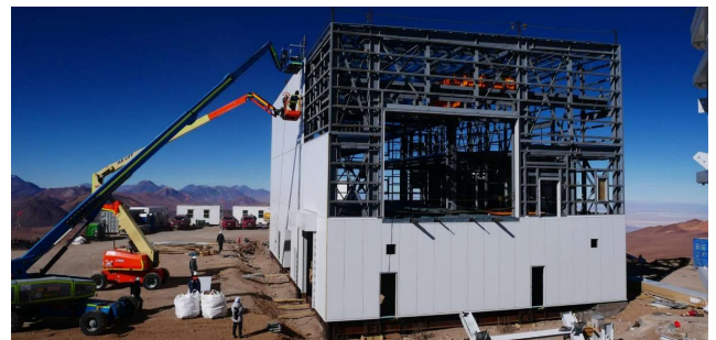
写真 5 外壁工事状況
