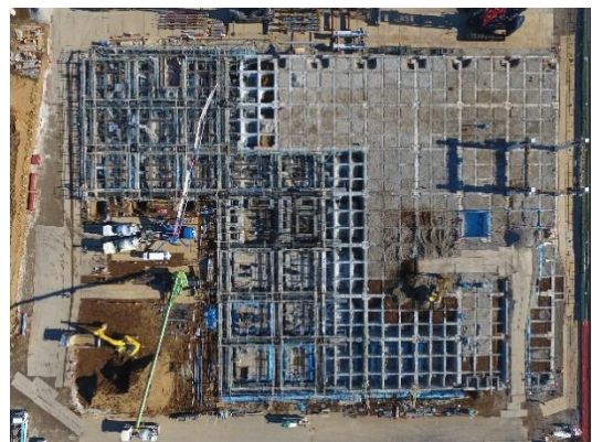
写真7 基礎工事全景
