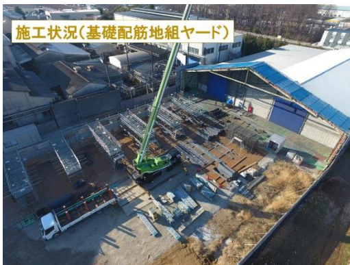
写真6 残土置場を利用した鉄筋地組ヤード
