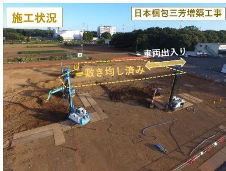
写真4 既存地盤との高低差減少
