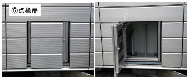
写真3 側面点検扉（左：閉時、右：開時）
