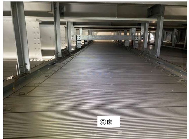
写真4 内部床面状況
