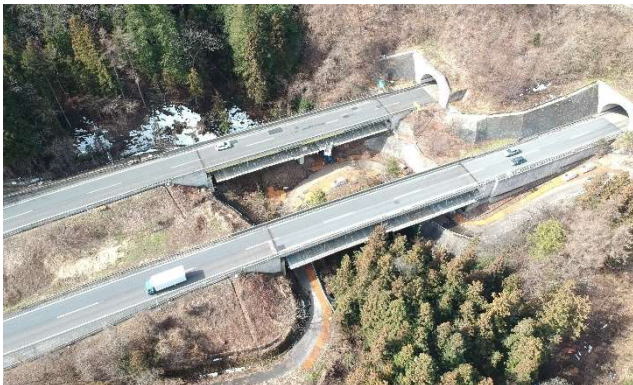
写真 1 中曽根川橋全景（完成）
