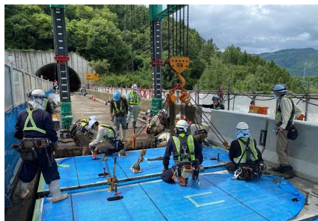
写真5 プレキャストPC床版架設状況
