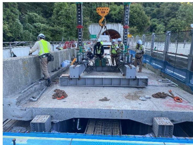
写真4 既設床版撤去状況
