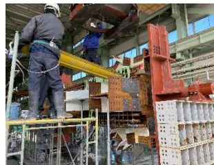
写真 12 先行打設状況
