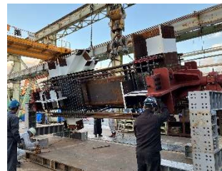
写真 13 鉄骨反転状況
