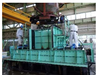
写真 6 基礎部材 (打設)
