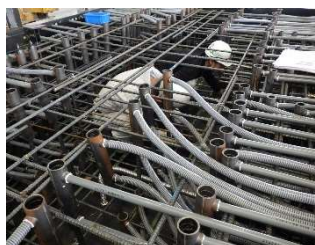
写真 4 排出口の設置
