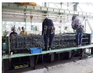
写真 5 基礎部材配筋
