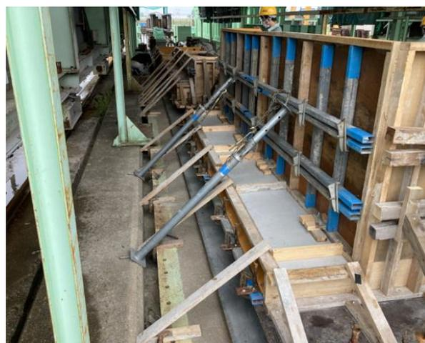
写真 7 壁高欄の施工試験の状況
