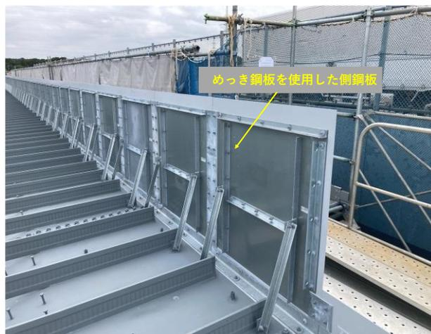
図 12 めっき鋼板を実橋に適用した事例
