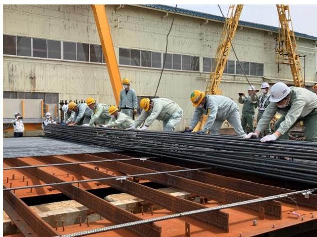
写真 9 プレファブ鉄筋の施工試験
