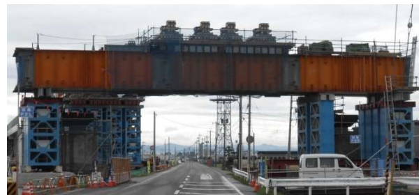
写真2 第1田島架道橋の門型ベント
