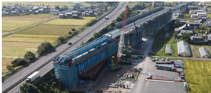
写真 6 武生架道橋の主桁送出し状況
