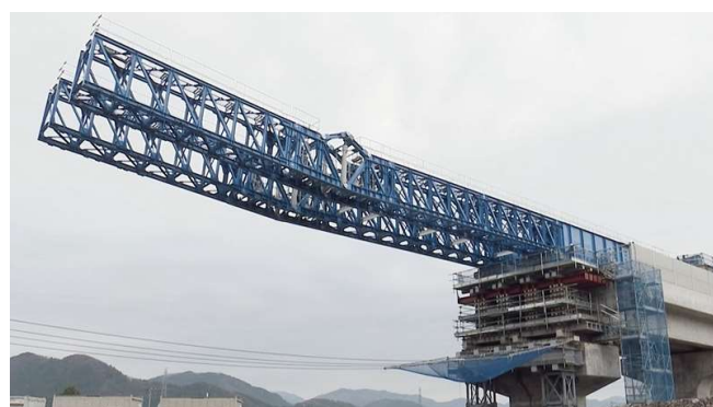
写真 4 パンタグラフ式手延べ桁
