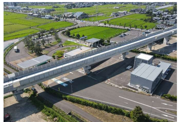
しんじょう (h) 第3庄架道橋
