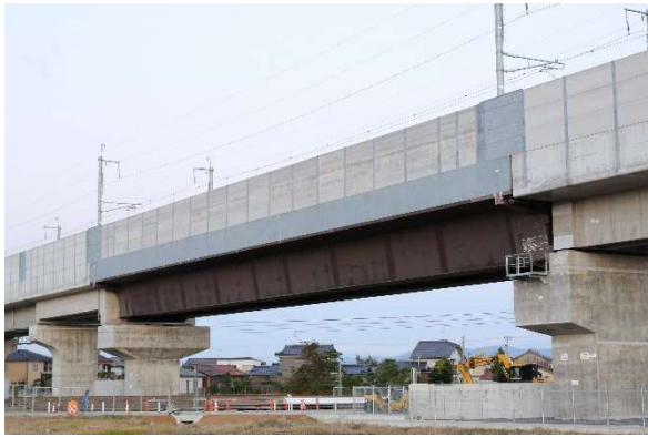
びるかわ (a) 蛭川線路橋
