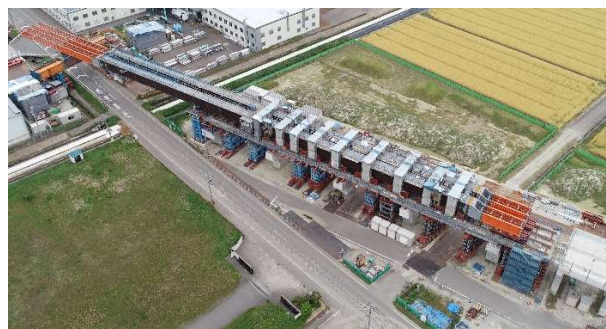
写真3 第1田島架道橋の作業構台の全景
