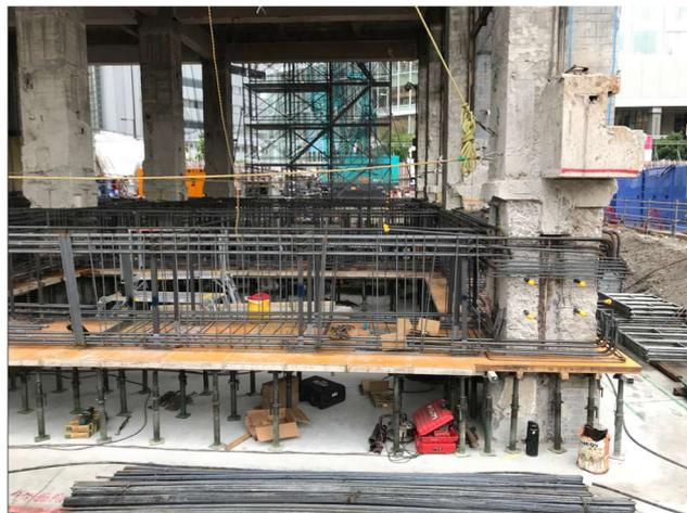
写真1 保存建屋補強梁増築状況
