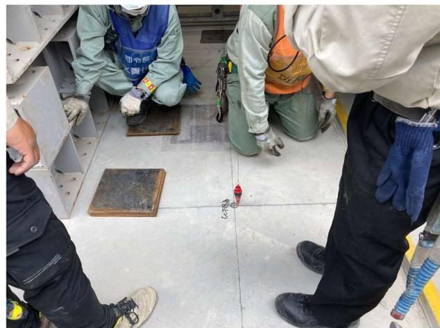
写真7 水平方向最終位置調整
