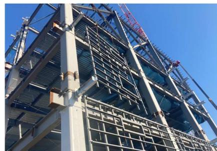
写真9 外壁を固定する為の胴縁鉄骨
