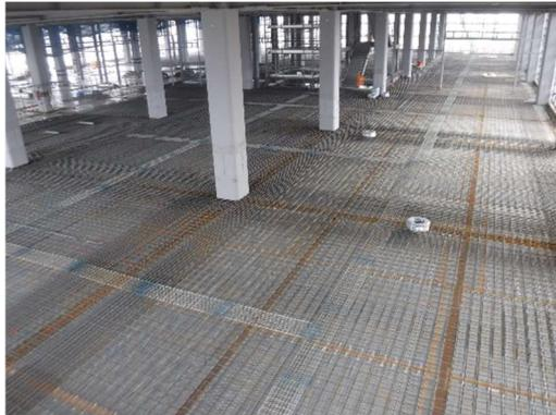
写真2 鋼製デッキ上のスラブ配筋状況
