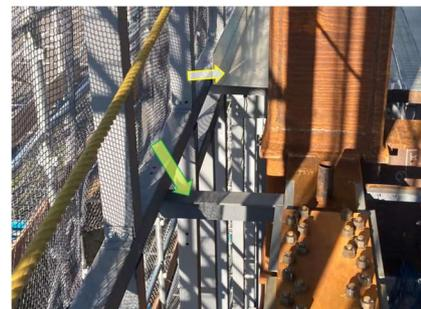
写真10 突き出したスラブデッキと受けアングル
