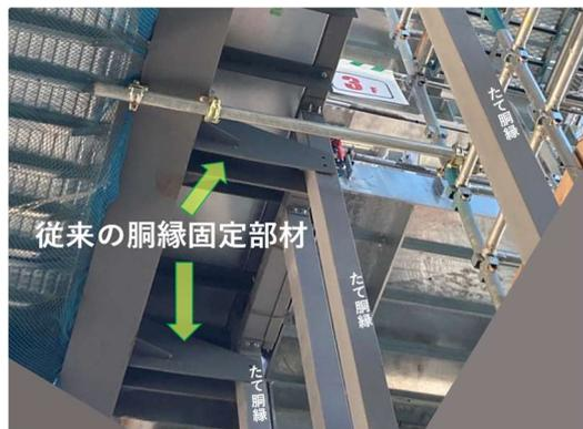
写真 11 縦胴縁を固定する梁ウェブからの持ち出し部材
