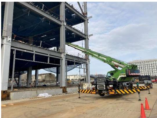
写真3 長物材料の搬入の様子
