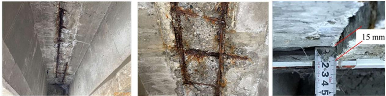
(a) 間詰床版のはく離・PC 鋼材露出 (b) 目地からの漏水 (c) 間詰床版の段差
