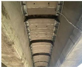
【縦横桁補強工法】
