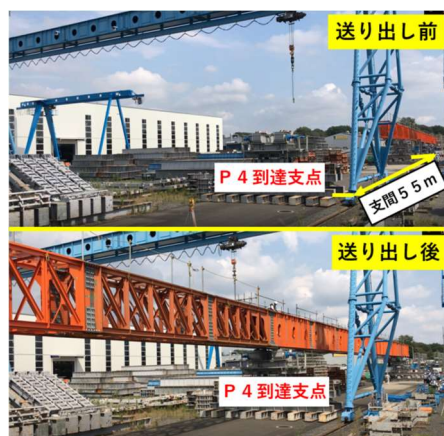
写真2 架設桁送り出し前後
