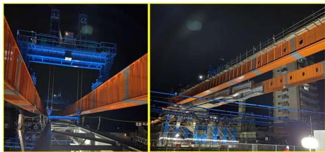
写真 8 主桁運搬状況
