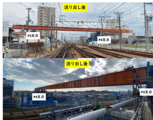
写真4 架設桁送り出し完了
