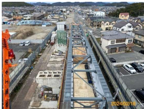
写真 5 仮設鋼材設置状況
