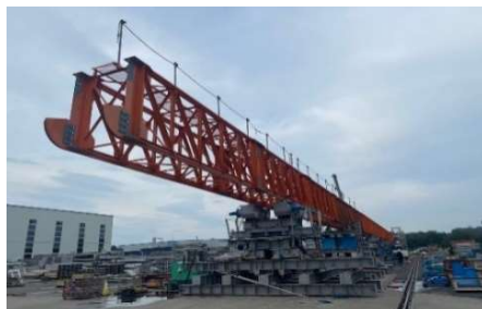
写真1 架設桁組立状況
