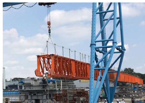
写真3 架設桁先端吊り上げ状況
