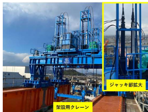
写真 6 架設用クレーン
