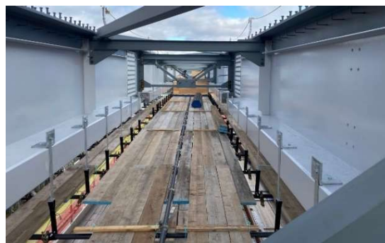
写真 10 桁間足場先行組立
