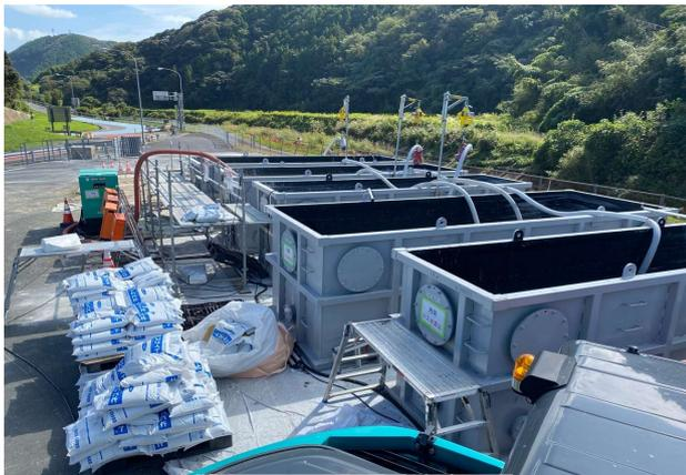
写真7 汚濁水処理施設
