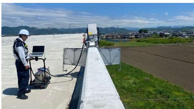
写真5 壁高欄点検状況
