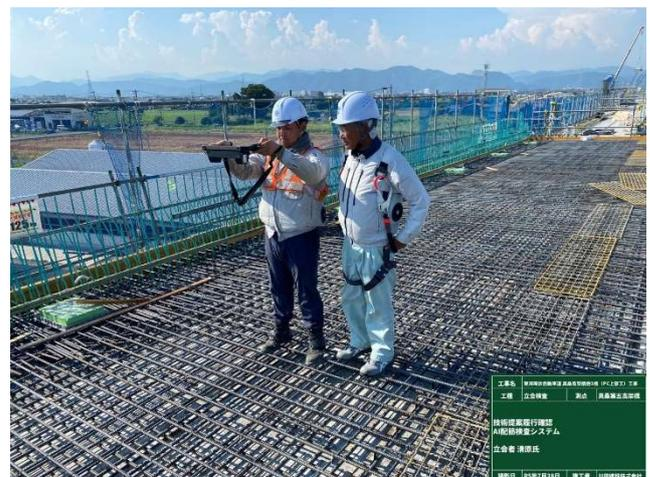
写真4 配筋計測状況
