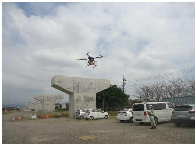
写真1 ドローン測量状況
