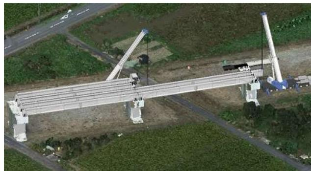
図3 3D-CADによる主桁架設計画
