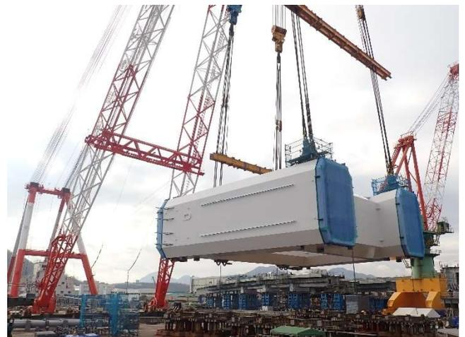
**写真 1** 大ブロック浜出し時の状況
