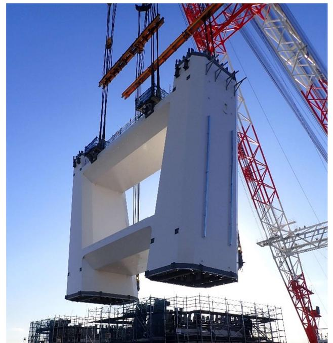
**写真 2** 主塔の大ブロック架設の状況
