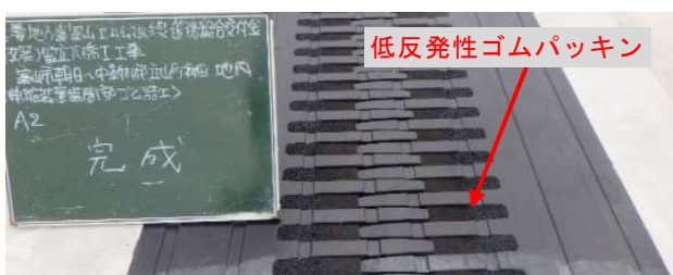
写真 4 ゴムパッキン設置状況
