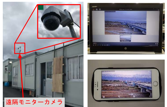
写真 6 遠隔モニターカメラの設置
