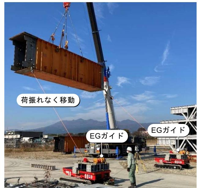
写真5 「EGガイド」の実証試験
