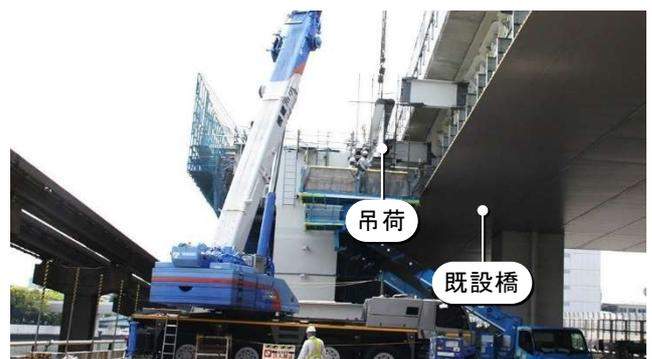
写真3 既設橋と近接する架設現場
