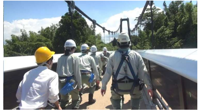
写真1 人力による強制加振状況
