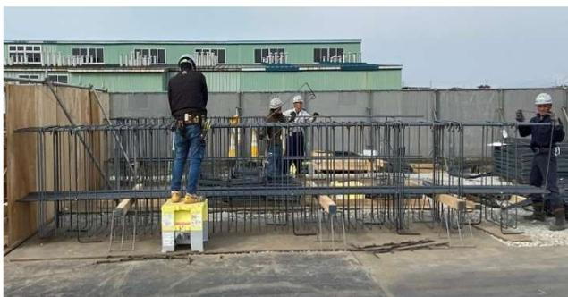
写真3 基礎梁配筋の先行地組の様子
