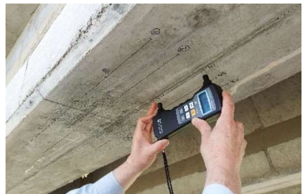
写真 1 超音波法の測定状況
