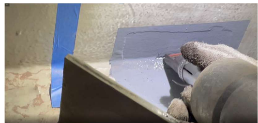
写真4 UIT施工状況
