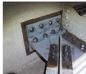
写真1 ガセット取替え完了
