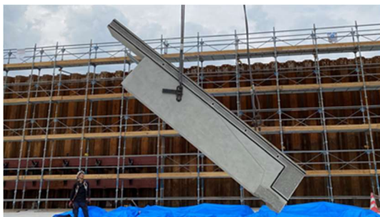
写真 2 部材建て起こし状況（壁柱）
