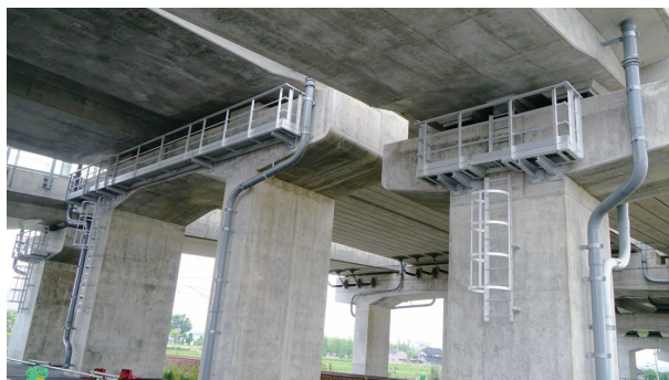
写真2 アルミ合金製検査路「ナロード」施工例
