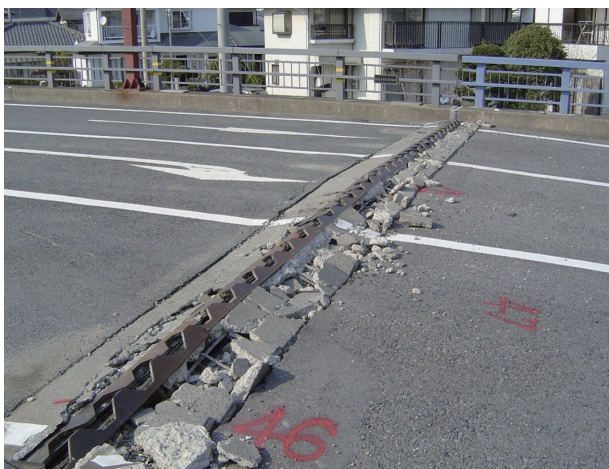
写真3 東日本大震災にて損傷を受けた伸縮装置
