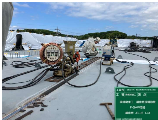
写真 9 F-SAW 溶接法による現場溶接
