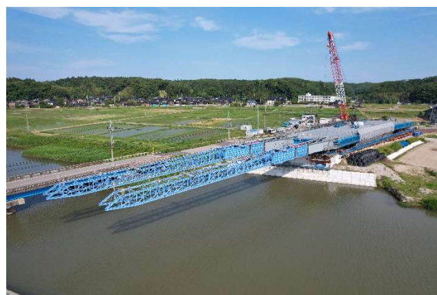
写真3 送出し架設状況（STEP-2）
