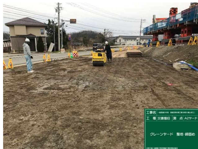
写真5 送出しヤードの整地
