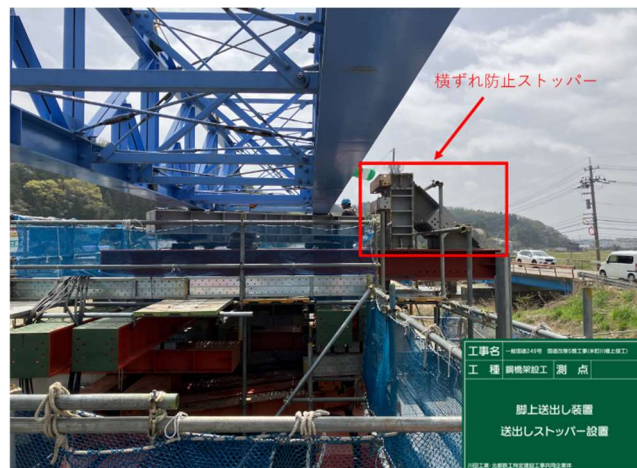
図5 送出し桁の横ずれ防止対策
