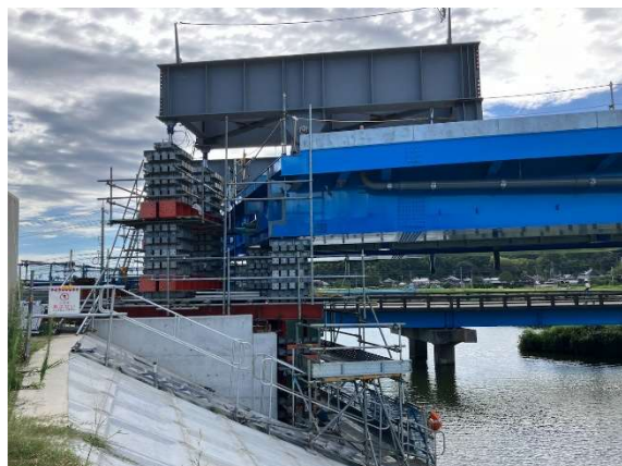
写真2 桁降下用セッティングビーム
