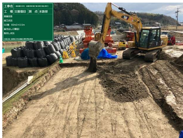
写真6 横断函渠周辺地盤の修繕
