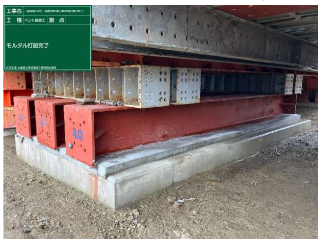
写真 7 高さ調整用モルタルの打設
