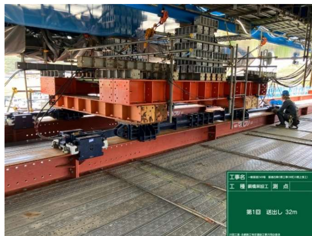
写真 10 台車の逸走防止対策
