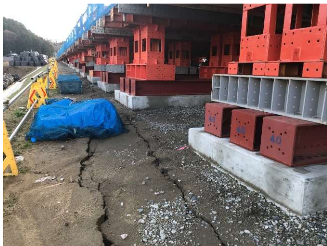
写真4 地震による地盤亀裂
