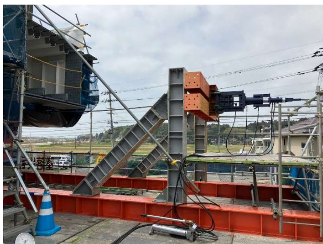
写真11 送出し桁の逸走防止対策
