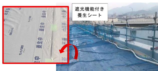
図 13 温度上昇を防ぐための鋼床版上の養生状況
