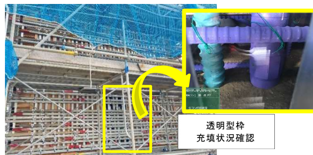
図 14 型枠支保工組立状況と充填確認状況
