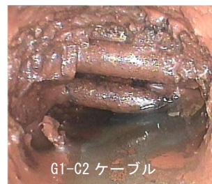
写真 2 滞水状況 (健全度 2)
