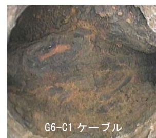
写真 1 PC 鋼材の状況 (健全度 5 相当)
