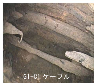
写真 1 PC 鋼材の状況 (健全度 5 相当)
