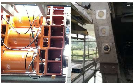
写真 6 5 000kN ジャッキ支圧箇所
