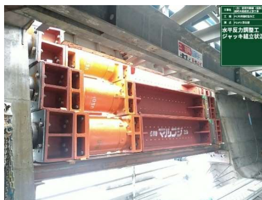
写真5 5 000kN ジャッキ配置（3段）
