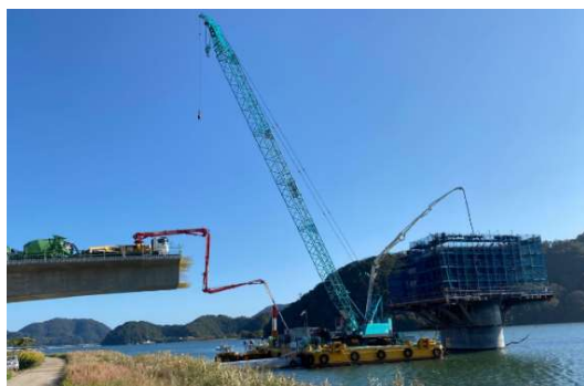
写真2 柱頭部コンクリート打設
