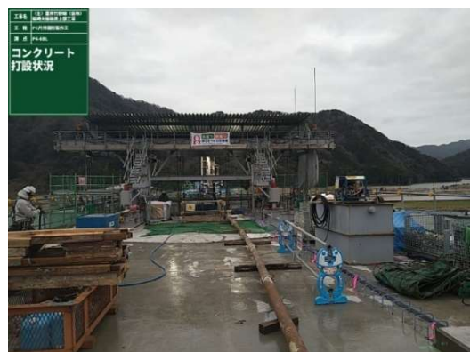
写真4 張出部コンクリート打設（橋面上）
