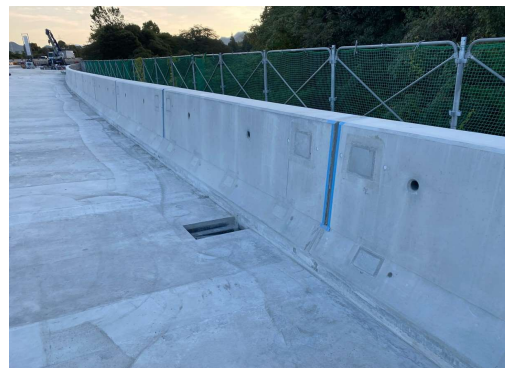
写真4 切欠き部モルタル充填
