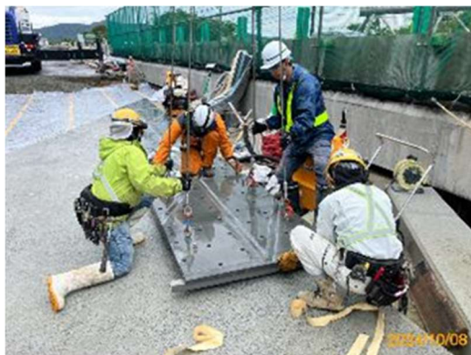
写真 5 薄肉高強度プレキャスト版設置状況
