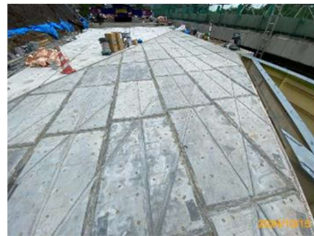
写真 6 薄肉高強度プレキャスト版設置完了
