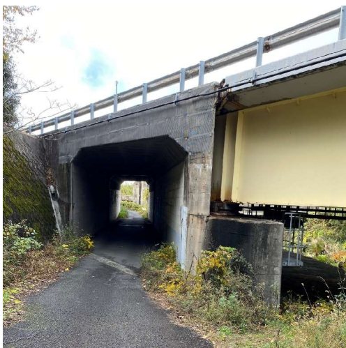
写真2 ボックスカルバートが一体となった橋台
