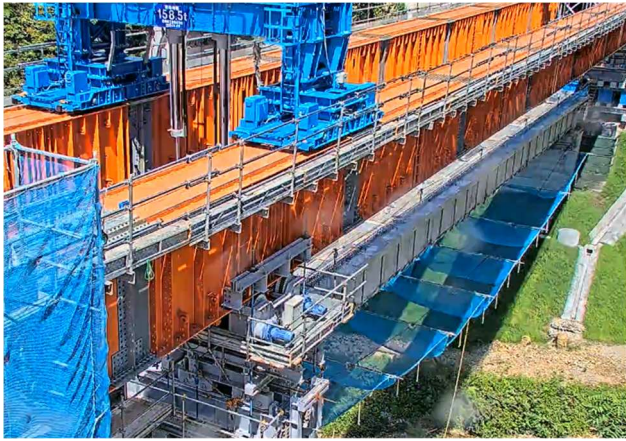
写真 5 架設桁架設状況
