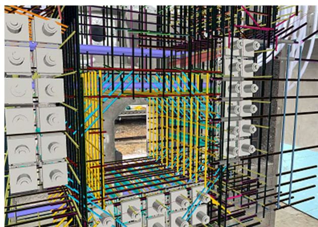
写真4 鋼材実配置状況と CG モデル重ね合わせ
