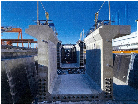
写真2 張出床版と水切り部の一体化
